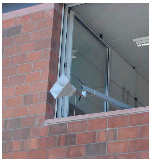
Fig. 5 Blick vom Parkplatz auf das Fenster von Raum 1 mit Hornantenne
